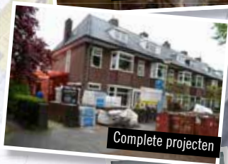
Dakkapel maken + plaatsen
